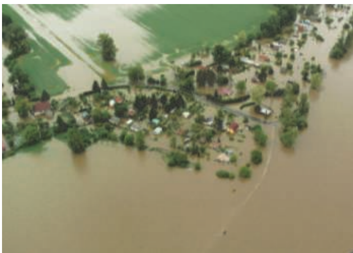
Přetékající protipovodňová hráz, foto: JMo
