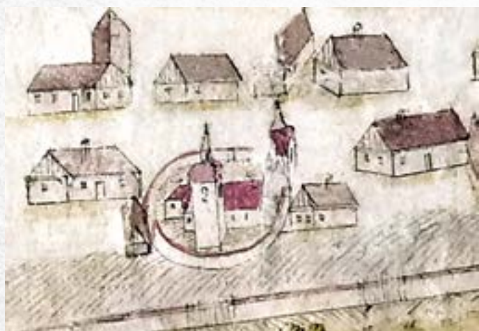
Kostel na mapě z roku 1744 od J. J. Manna se hřbitovní zdi a samostatně stojící zvonici
