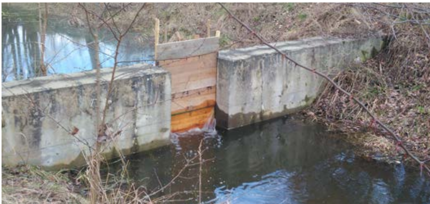
Propustek na Kubantově
