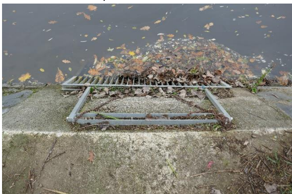
Vtok napouštěcího zařízení
