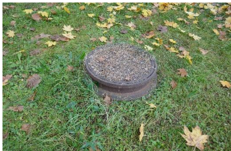
Kanalizační vpusti, kterými jsou pozemky zaplavovány
