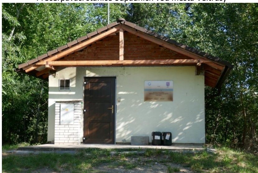
Přečerpávací stanice odpadních vod města Veltrusy
